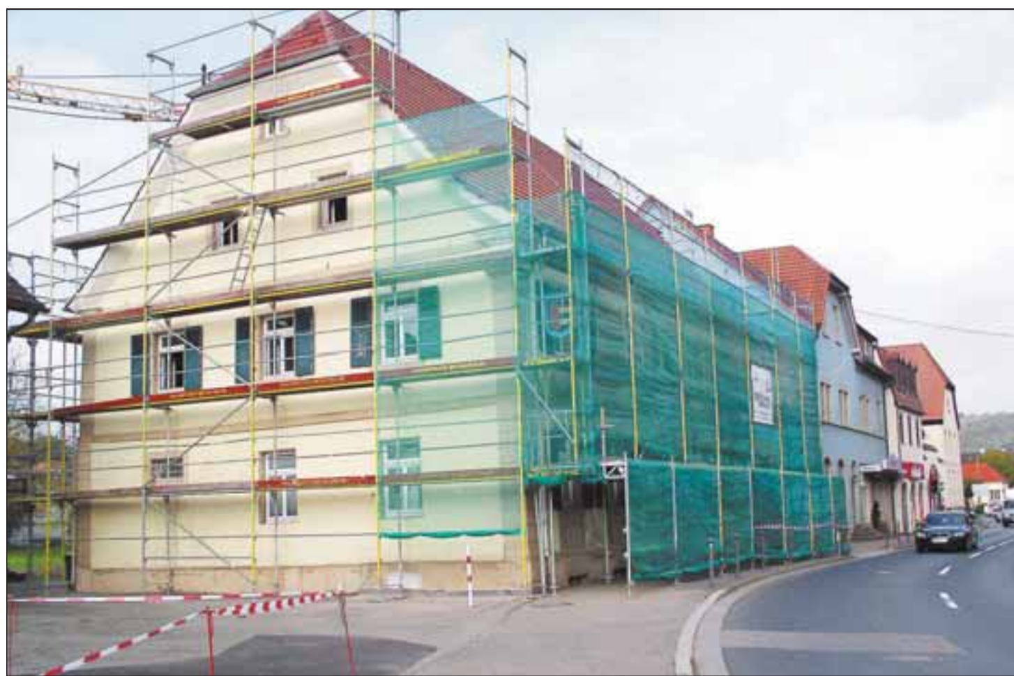
Mitten in Hoffenheim: An der Verwaltungsstelle werden im Rahmen der Ortskernsanierung Reparaturen vorgenommen. Vor allem Gebäudeschäden im Dachbereich werden behoben, eine neue Decke eingezogen. Foto: Heß
